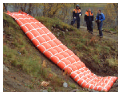
Prototyp av MARECOM-matten under utstøpningsfasen.
